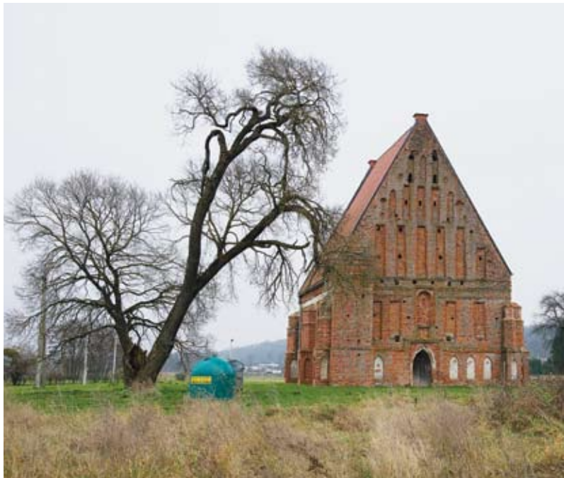
Senosios Zapyškio bažnyčios fasadas
