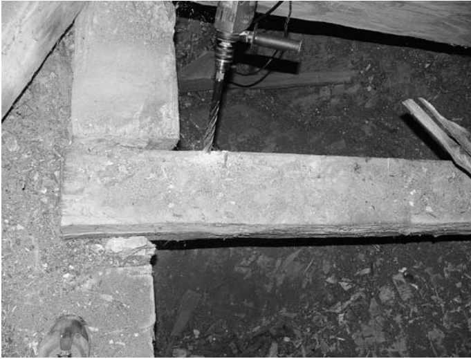
2 iliustracija. Perdangos sija virš presbiterijos, datuota 1572 m. Nuotraukoje matyti medienos mėginių paėmimo gražtas. Adomo Vito nuotrauka, 2018
