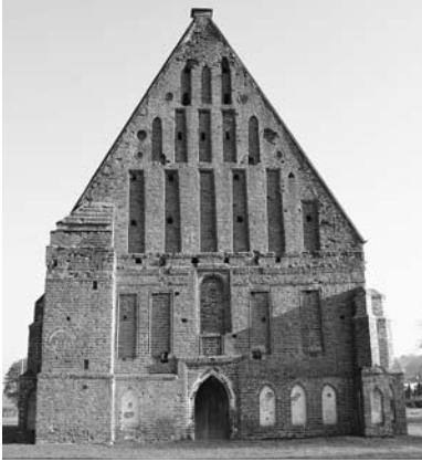
Zapyškio bažnyčios stačiakampės nišos vakarų fasade, Guodos Gediminskaitės nuotrauka, 2012
