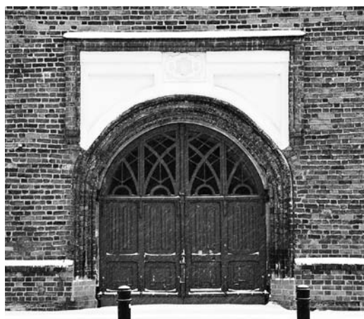
Kauno Šv. Petro ir Povilo bažnyčios profiliuotas portalas su staičiakampiu apvadu vakarų fasade, Guodos Gediminskaitės nuotrauka, 2013
