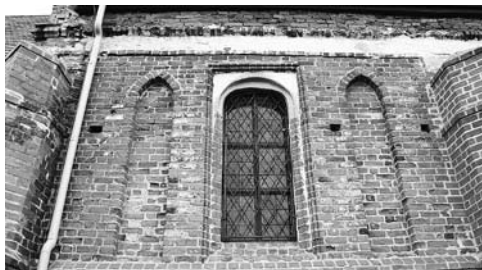
Zapyškio bažnyčios buvę smailiaračiai langai (XVIII a. pakeisti į segmentinės sąramos langus) su stačiakampiu apvadu šoniniuose fasaduose, Guodos Gediminskaitės nuotrauka, 2012
