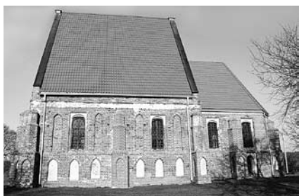
Zapyškio bažnyčios smailiaarkės nišos tarp langų šoniniuose fasaduose, Guodos Gediminskaitės nuotrauka, 2012
