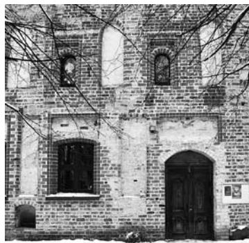
Kauno bernardinų vienuolyno pusapvaliai langai su stačiakampiu apvadu vakarų fasade, Guodos Gediminskaitės nuotrauka, 2013
